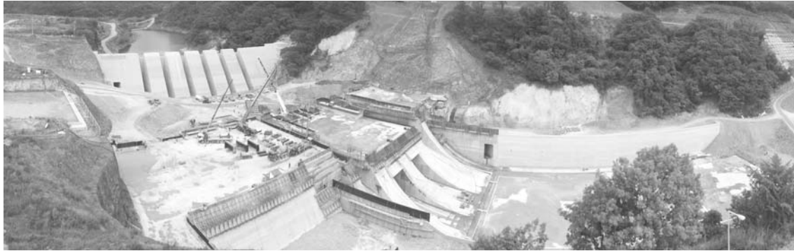
그림7. 한탄강홍수조절댐 공사 전경(2012년 8월)
