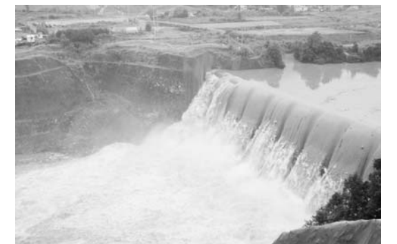
그림 6. 상류가물막이댐 월류 전경
