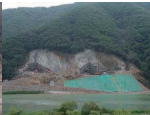
구조물 시공 전경
