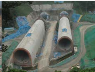
구조물 시공 전경
