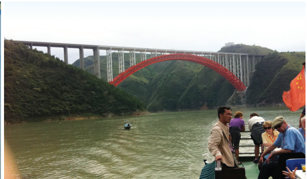
사진 10. 건설중인 고속도로 교량
