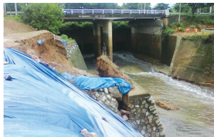
(5) 교량 하부 축대 붕괴
