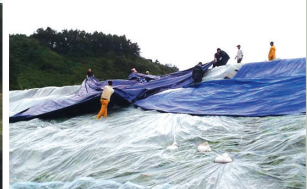
(4) 제방 사면 보호포 설치
