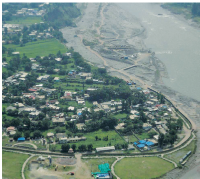
그림 2. 파키스탄 파트린드 수력발전 사업 공사현장 전경
