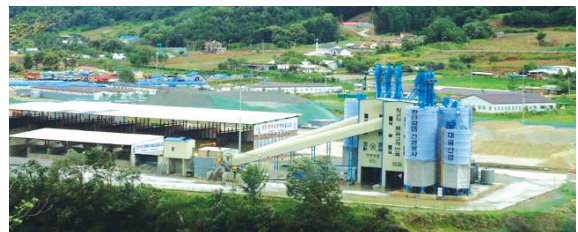
(a) 콘크리트혼합설비 전경
