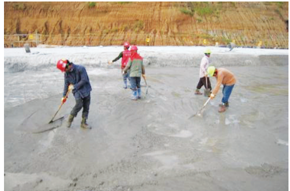
그림 17. RCD Mortar 포설
