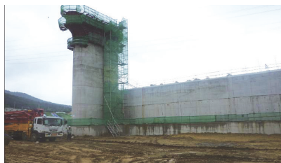
고정보 피어 거푸집 및 워킹타워 · 비계설치
