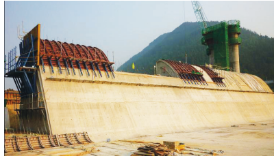
고정보 거푸집 설치
