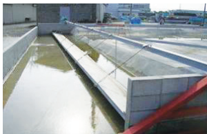
하류 수위조절장치 설치
