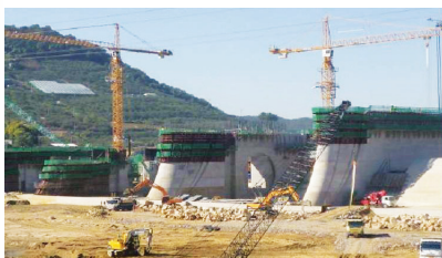
가동보 콘크리트 타설
