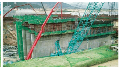
소수력발전소 상부벽체 Con'c타설
