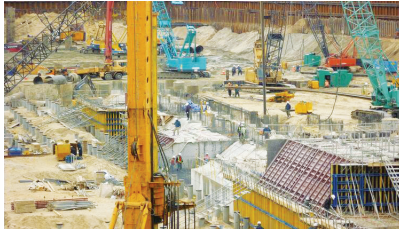
고정보 기초 콘크리트 타설
