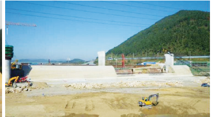
고정보 콘크리트 타설
