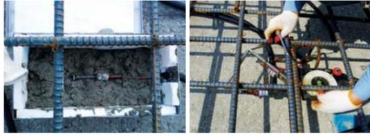
그림14. 무응력계 및 차수벽 변형률계 설치
