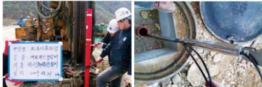
그림10. 경사계 케이싱 및 자동계측센서 설치
