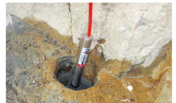
그림 7. 심도측정 및 간극수압계 설치\_2
