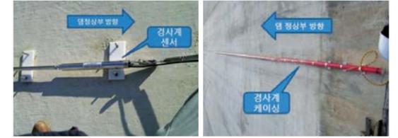
그림12. 고정식 경사계 센서 및 케이싱 설치
