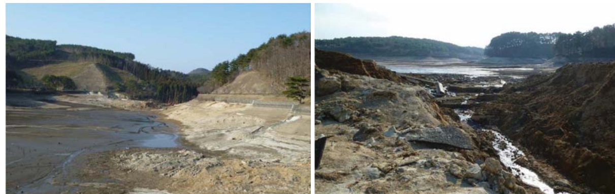
그림-5 Tohoku지진시 붕괴된 Fujinuma댐 (Matsumoto, 2012)
