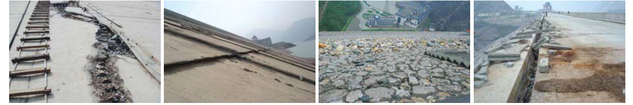
(a) 콘크리트 슬라브의 압출 (b) 콘크리트 슬라브의 겹침 (c) 하류 사면의 느슨해짐 (d) 댐마루 구조물의 손상
