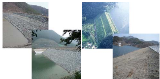
영천댐 상류사면 재시공('04) 안계댐 상류사면 재시공('05)
