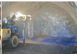
② 슛크리트 타설
