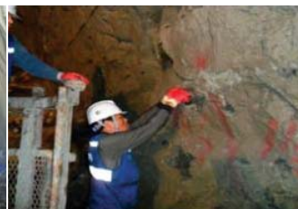
③ 락볼트 시공
