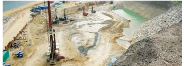
가물막이 NPJ, MIS 그라우팅 천공 및 주입
