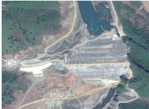
〈그림 3〉 임진강 본류 상류에 건설중인 원산군민발전소 저류용 댐
