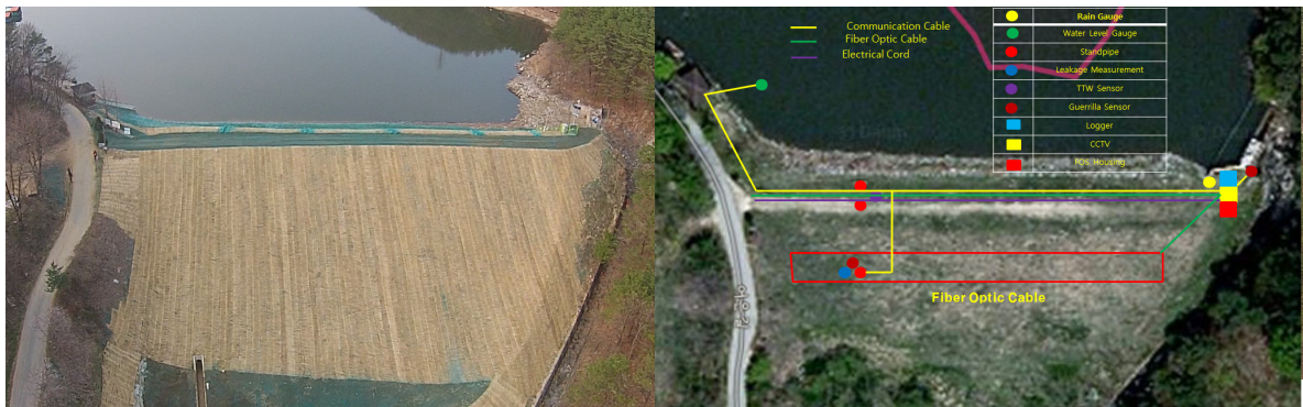
〈그림 4〉 사례지구 전경 및 센서 설치 현황
