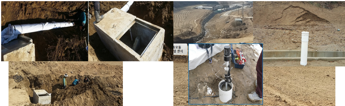
〈그림 6〉 (좌) 누수영역에 누수계 설치 (우) 비주얼 센서를 통한 실시간 모니터링
